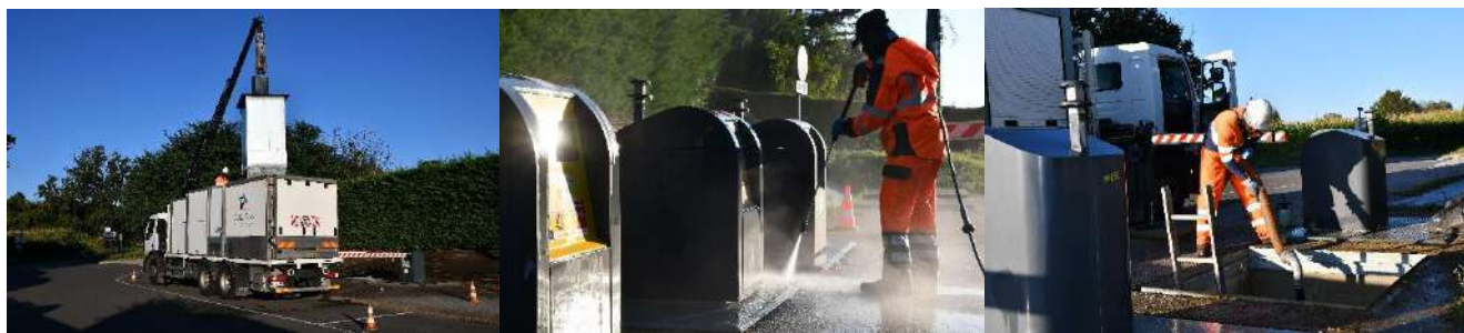
Figure 20 : Photographies du lavage des colonnes d'apport volontaire
